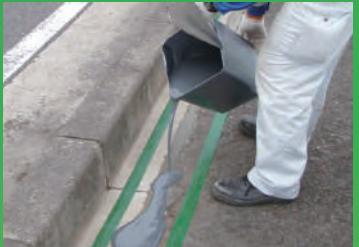
ウィードコート工法は舗装と縁石などの界面、隙間に生える雑草の発生を防止するものです。接着性・耐候性・耐薬品性に優れ、下地の伸縮にもよく追従する2液常温硬化型のポリウレタン樹脂 "ウィードコート" を塗布し、雑草の発生を防止する工法です。"ウィード"とは草を取ってきれいにすることを意味し、新設や既設歩道、中央分離帯等の界面やジョイント部に適応します。
